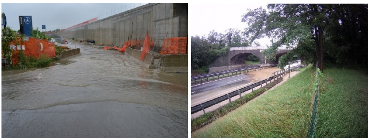
Figura 6: Esondazione del torrente Arno. A sinistra sulla SS341 presso il ponte di pedemontana. A destra, sulla A8 tratto Castronno-Solbiate Arno (fonte: www3.varesenews.it )
